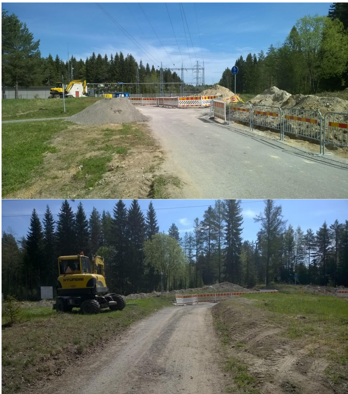
Kuva 11. Osa-alueen 3 tilanne 14.5.2016 kuvattuna pohjoiseen (ylempänä) ja itään (alempana). (Kuvat: Juha Pöyry)
